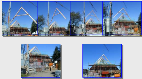
Teilweise Erneuerung des Dachstuhls
